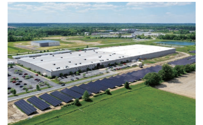
TS TECH INDIANA, LLCで新設された太陽光発電設備
