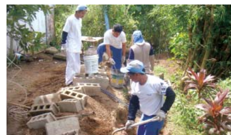
老人ホームのブロック塀を造成 [テイエス テック トリム フィリピンズ]
