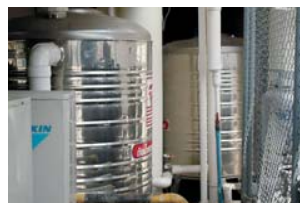
再利用のための雨水槽を設置 [ティエス テック(タイランド)]
