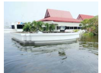
洪水被害を受け、建屋が浸水したティエス テック(タイランド)
