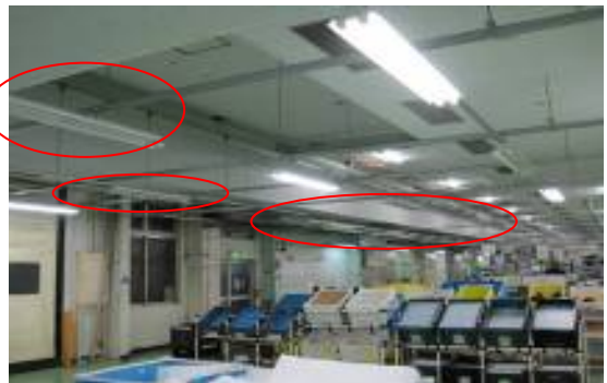
埼玉工場 (川越) 第4工場
