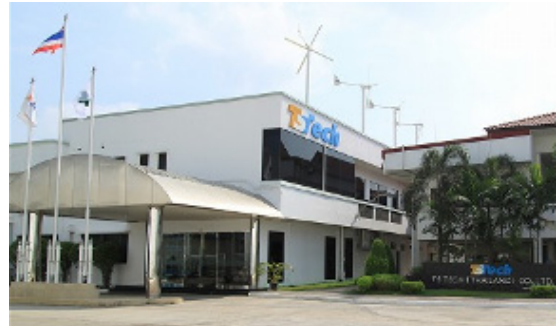
タイ第1工場屋上に設置された風力発電施設
