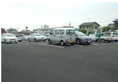
駐車場騒音対策 (全面アスファルト舗装の駐車場)
